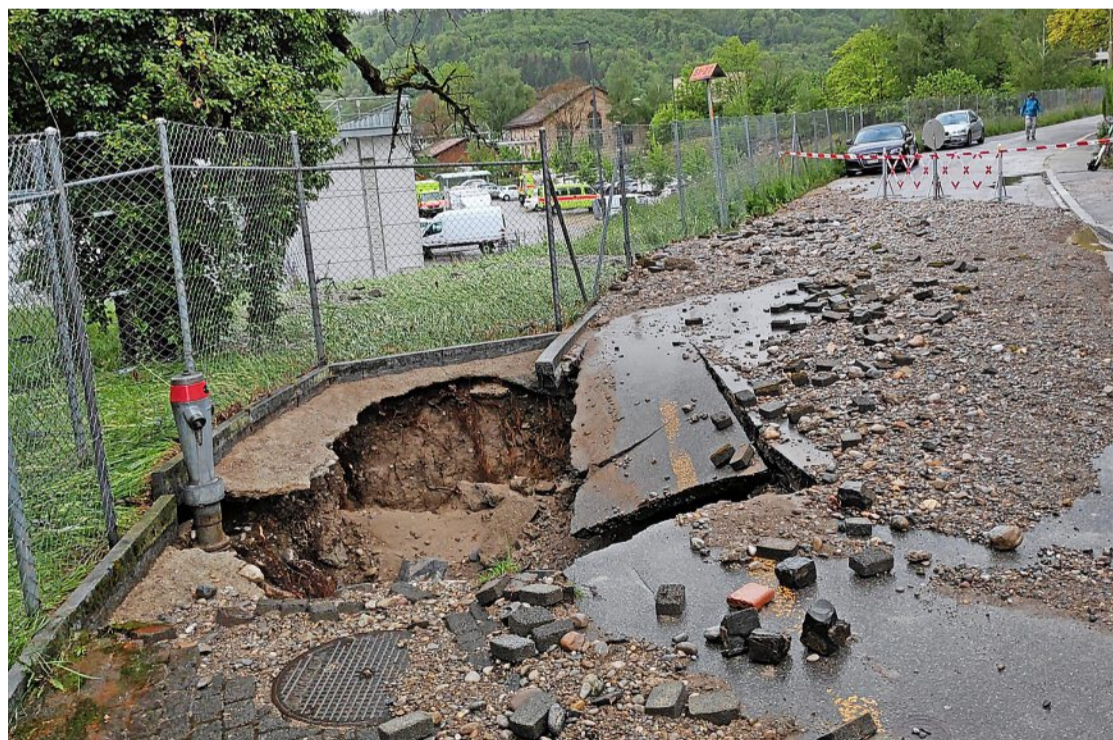
1200 Liter pro Sekunde schossen hier in der Nacht auf Montag aus dem Boden. Die Wassermassen schwemmten Steine bis zur Zürcherstrasse hinunter (r.). Fotos: Leserbilder
