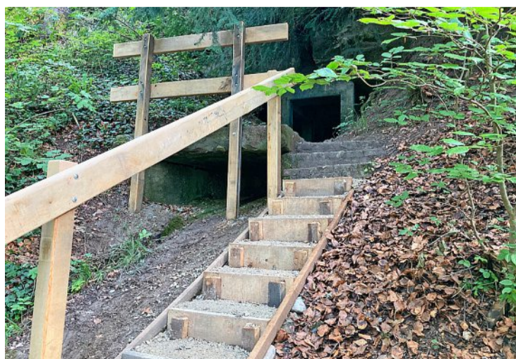
Eine frisch erstellte Treppe mit Handlauf führt hinauf zur Quelle. Foto: PD
